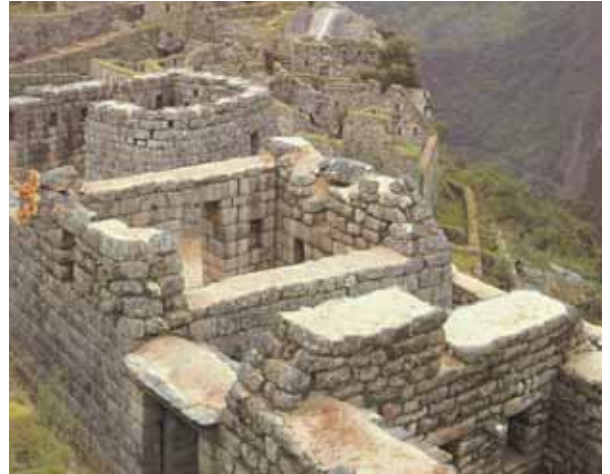
La construcción sin Mortero ha servido para las centurias.
