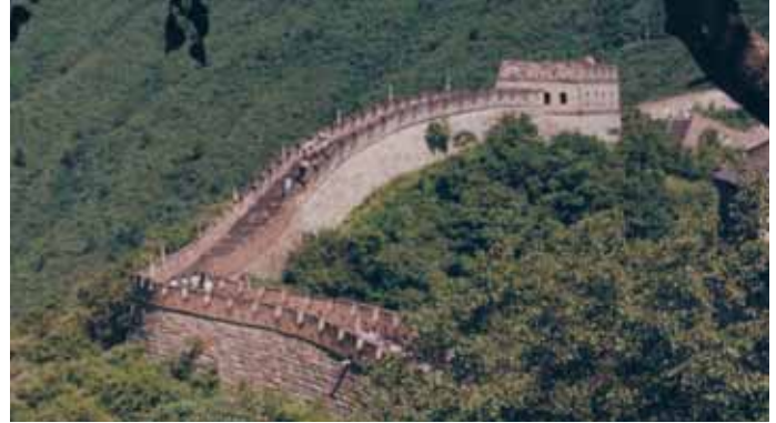
La Gran Muro de China, que se origino hace 2,200 años, fue construida como un muro de retención de doble lado. El suelo entre los dos muros, fue una mezcla de arcilla y grava reforzada con ramas de Tamarisko. Los muros de Allan Block emplean "Tecnología antigua con materiales nuevo."
